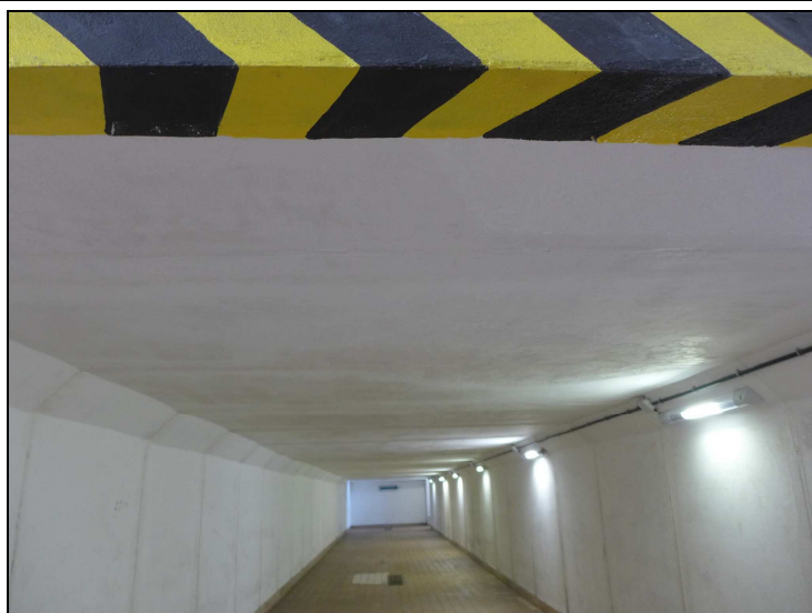
1. K 01 – podhled – stopy po průsacích vody
