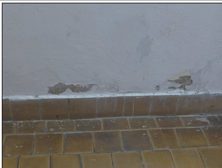
2. O 01 – odpadaná povrchová úprava v dolní části
