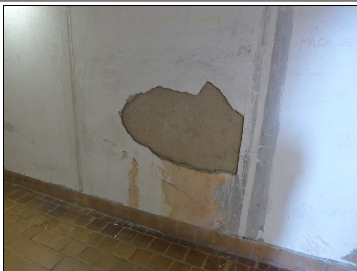
3. O 01 – pravá část – odpadlá omítka a stopy po stékání vody
